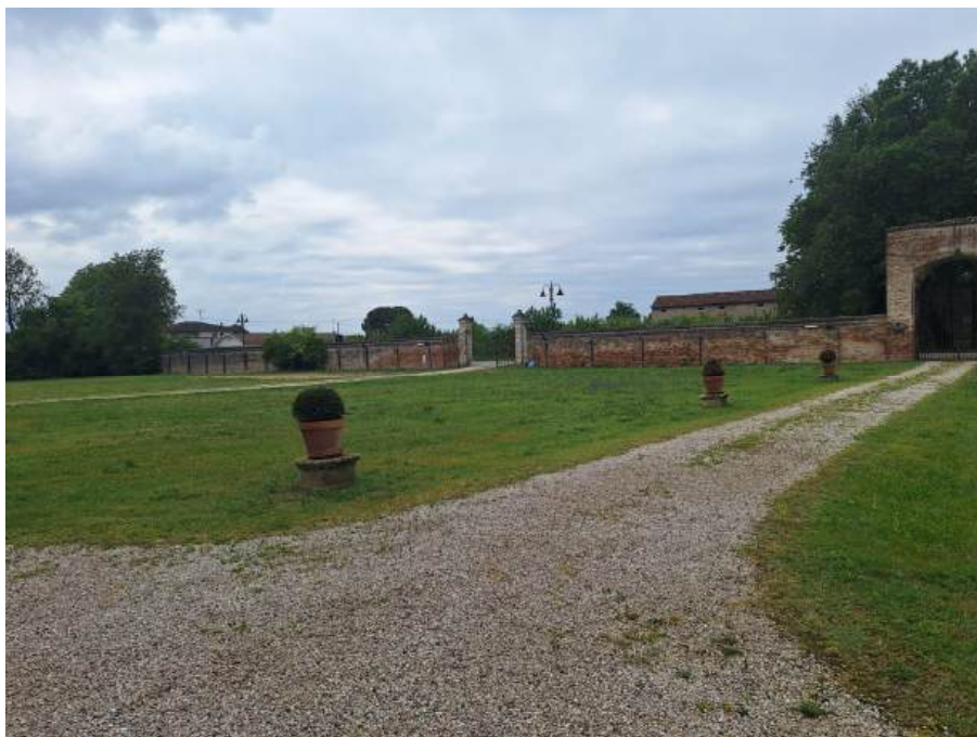
CRITICITA' 7 e 8 – Vista della strada di collegamento tra Villa e via principale e di area destinata a parcheggio
