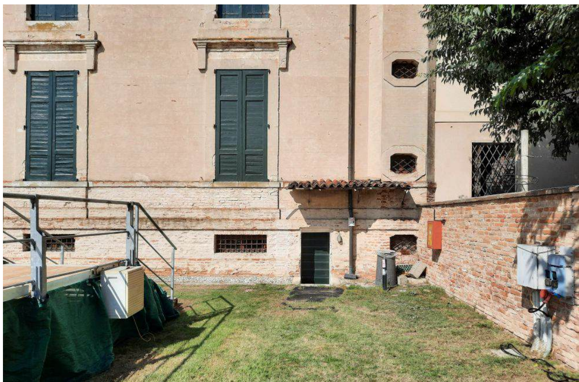
Fig. 8 – Ingresso al piano interrato – Prospetto Est
