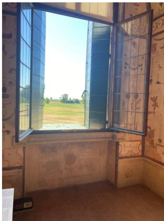
Fig. 15 – Dettaglio interno – Piano nobile
