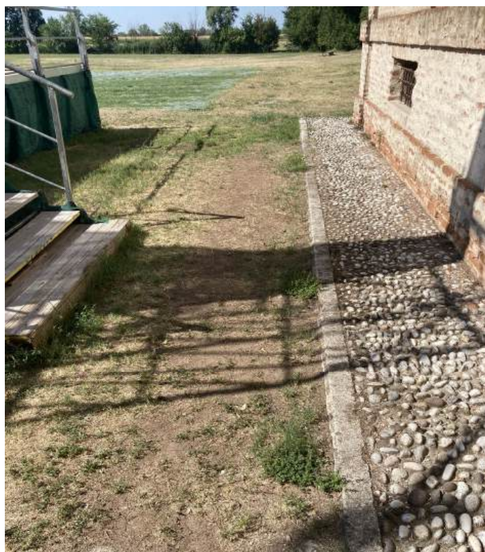
Fig. 10 – Dettaglio marciapiede in ciottoli lungo il perimetro della villa
