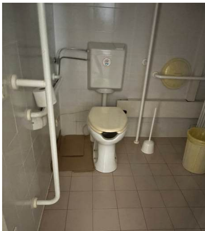
CRITICITA' 1 – Vista dei servizi igienici
