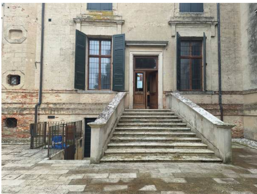
CRITICITA' 6 – Vista di ingresso alla biglietteria al Piano Nobile
