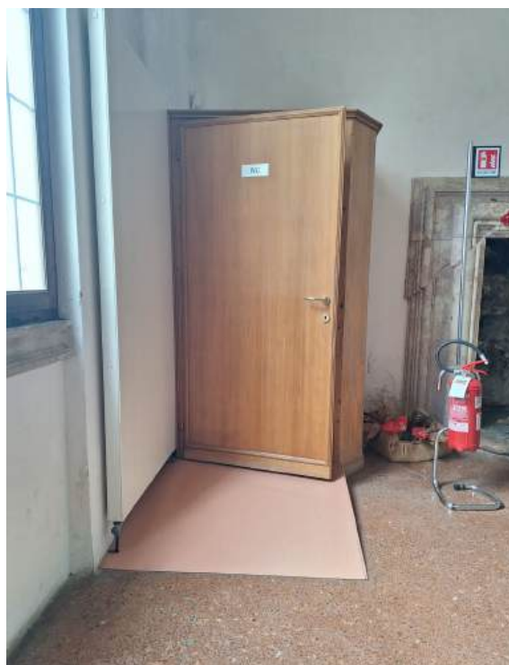
CRITICITA' 1 – Vista dell'ingresso al servizio igienico
