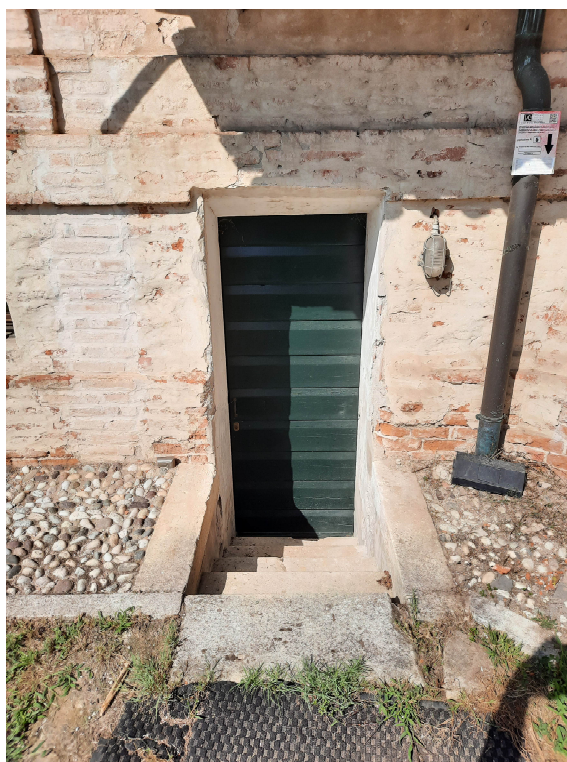
CRITICITA' 6 – Vista delle scale di accesso al piano interrato sul retro della Villa
