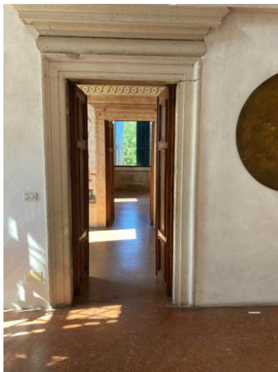
Fig. 14 – Dettaglio interno – Piano nobile
